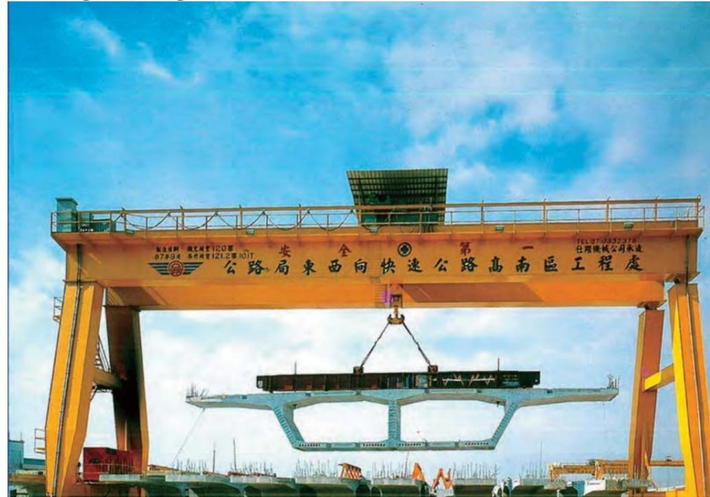
● 120T 門型吊車 120T Gantry Crane
