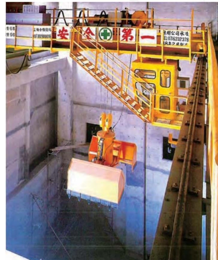
● 飛灰固化物吊車 Ash Solidification Crane
