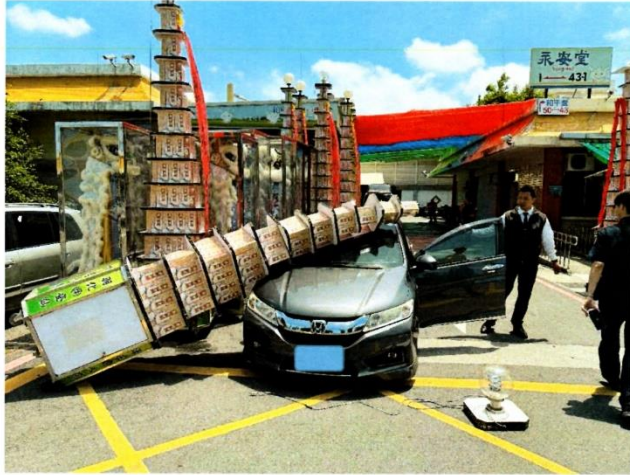
照片說明二：米塔過高，受風面積大容易倒塌
