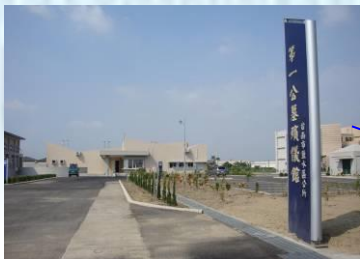
鹽水區殯儀館
