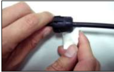
以酒精清潔光纖及橡膠斷面
